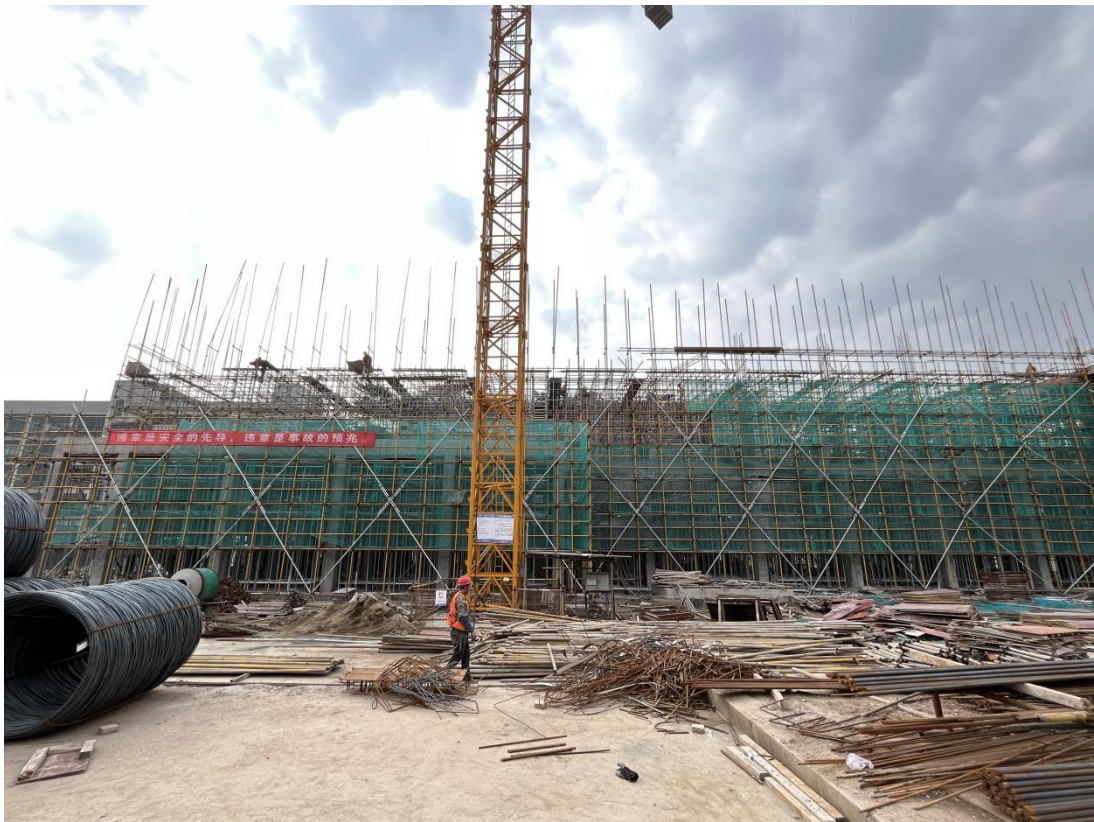
项目区施工场地现状
