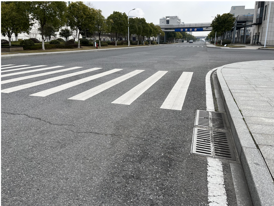
项目区内雨污管网现状
