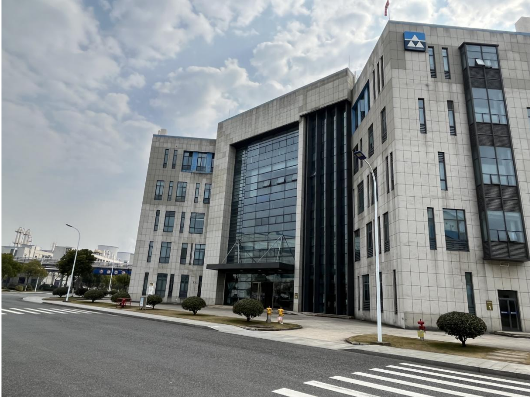
项目主体建设现状 1
