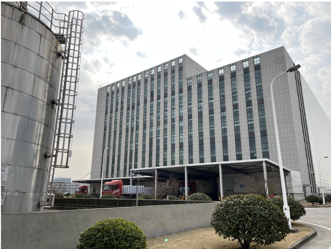
项目主体建设现状 2
