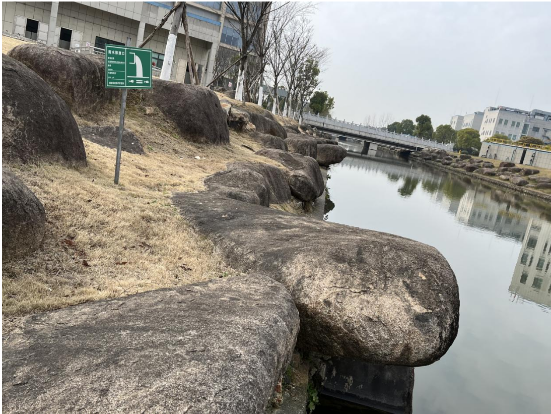
项目区内雨水排水现状（雨水排放口）
