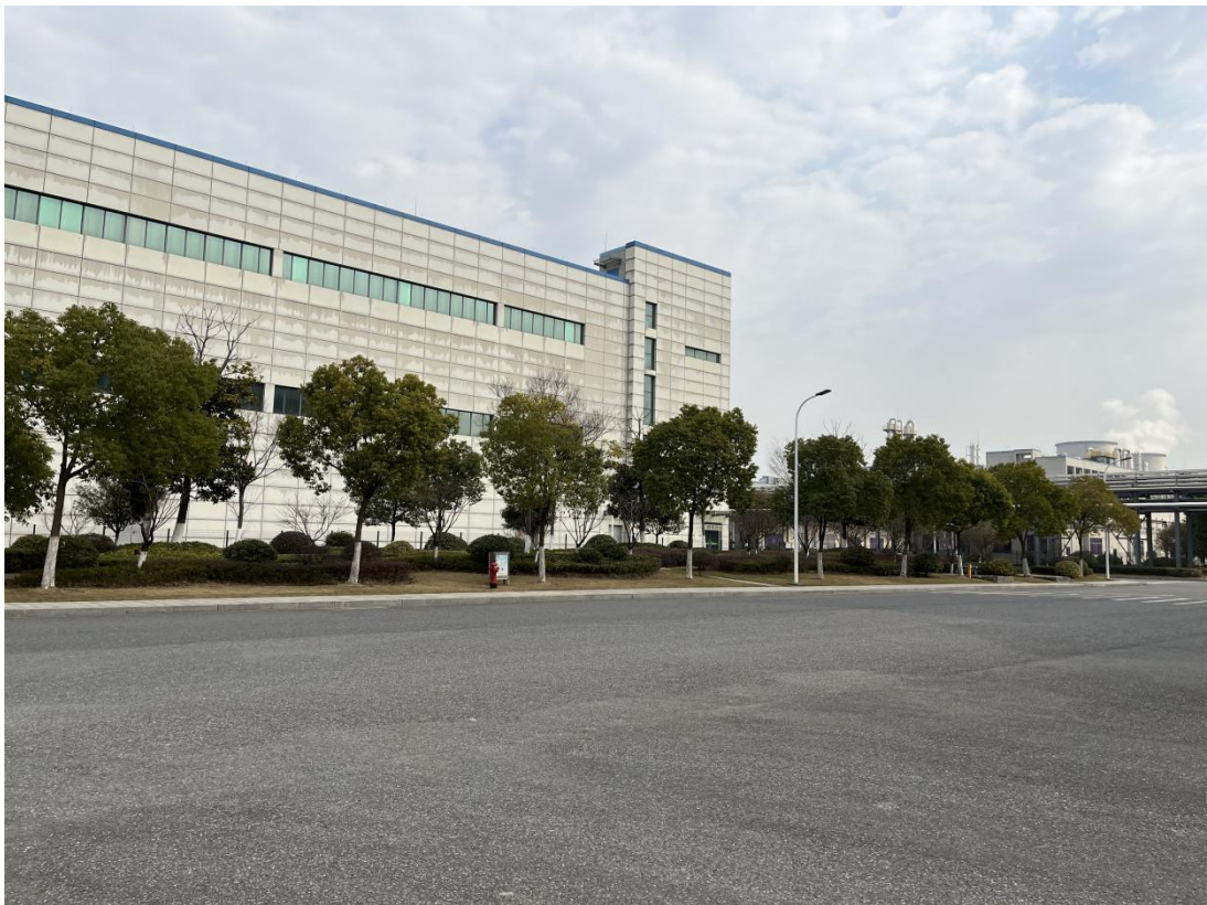
项目道路硬地现状 2
