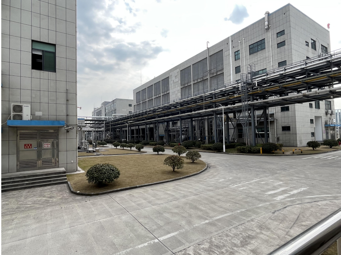
项目道路硬地现状 1
