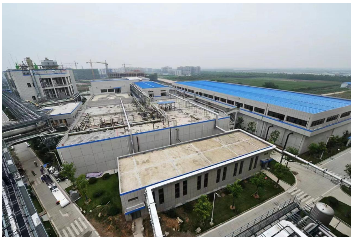
污水处理设施
