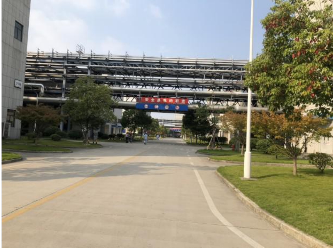
附图 6 环保制度和污染源标识标牌上墙及危废仓库照 附图 7 厂区绿化照
