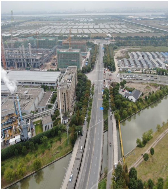
项目西侧-南滨西路
