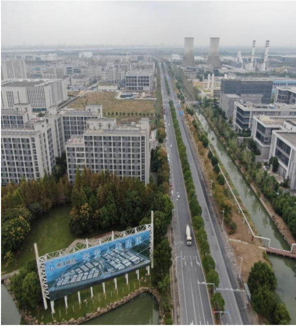
项目东侧-越中路
